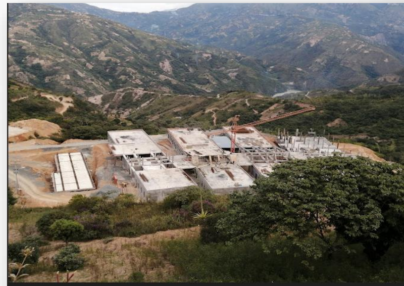
Hospital de Segundo Nivel – Coripata en el Departamento de La Paz
