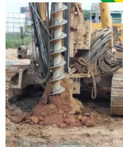
Excavación de pilotes
