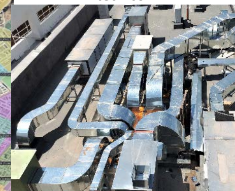
Tratamiento de aire – ductaje exterior sobre terrazas
