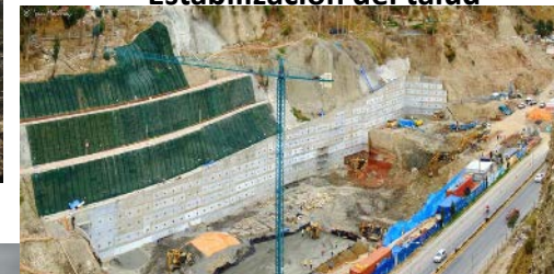
Construcción de Muros con Placas Ancladas de Hormigón
