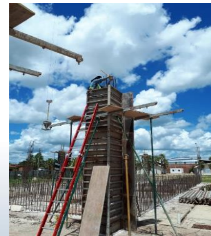
Armado y vaciado de columnas
