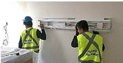
Instalación de cabeceras de camas hospitalarias
